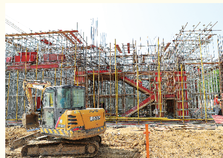
5月是快速推进工程建设的黄金期,临港开发区围绕项目建设积极布局,确保重点项目稳步推进。图为鑫丰生物经济产业园项目正在加快建设。
