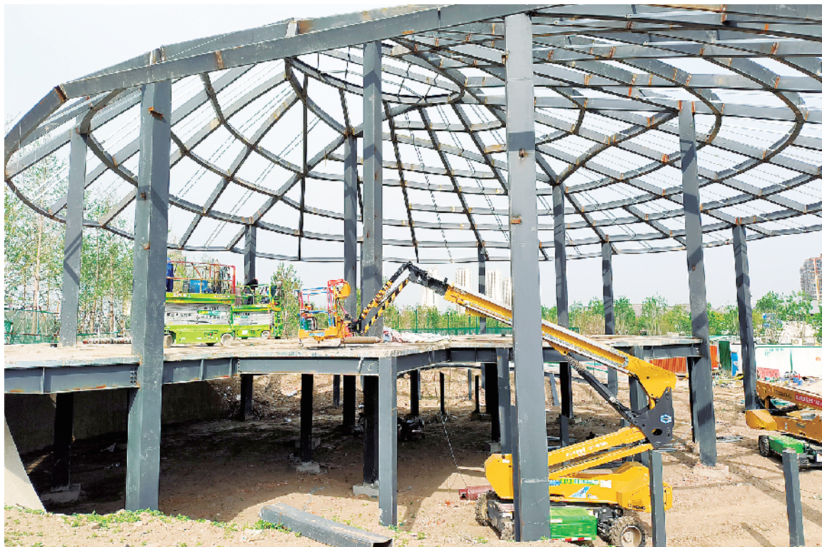
4月17日，几台施工机械正在市民驿站施工现场作业。正在施工的这座市民驿站坐落于关帝老街东南部，为两层钢架结构，投入使用后可为市民提供休憩观光等便利服务。 记者 沈湛 摄
