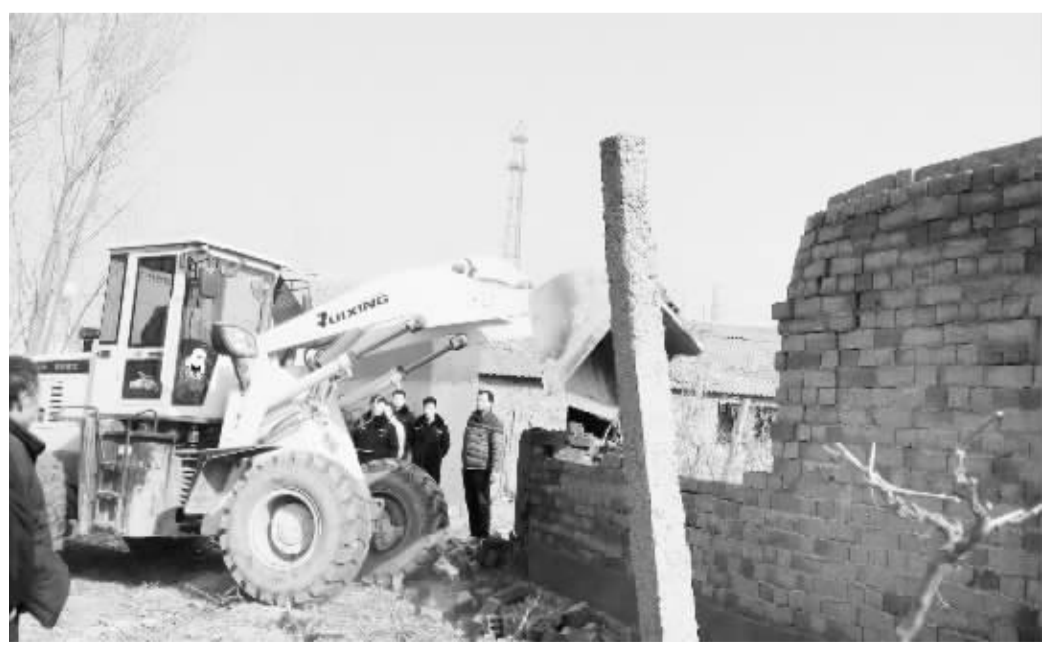
川汇区金海路办事处坚决维护“两违”治理成果,对“两违”建筑做到发现一处、拆除一处,为辖区经济社会发展创造了良好环境。图为办事处组织人员对一处违法建筑进行拆除。
